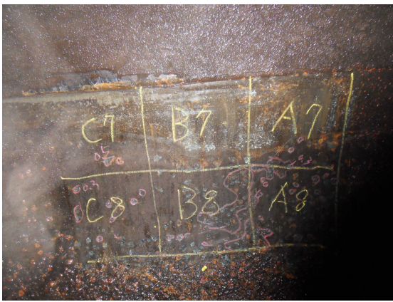
【관 내면 상태검사】
