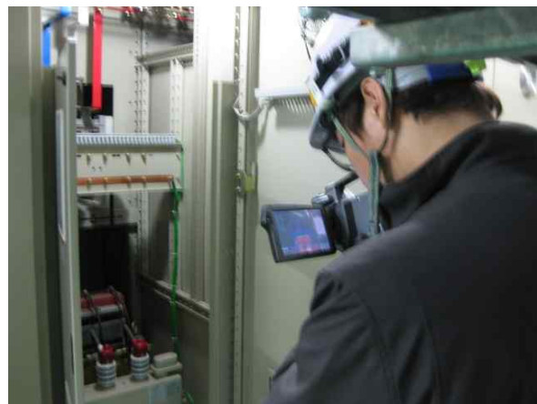
【적외선 열화상 촬영】
