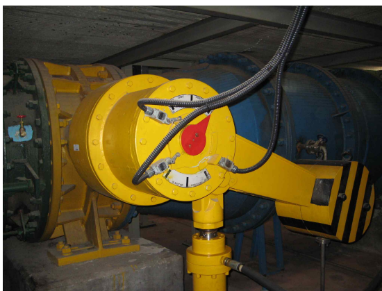
【체크밸브(Tilting Check Valve)】
