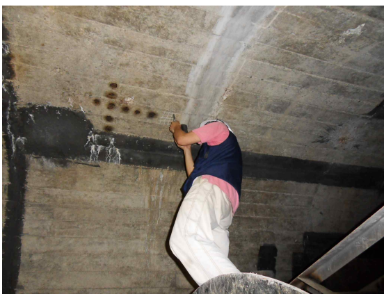
【콘크리트 강도 측정(반경경도법)】
